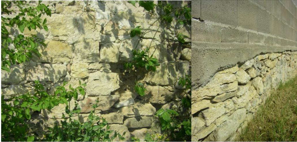
**Abb. 6: Mauerreste (Fugen und Spalten vorhanden)**
